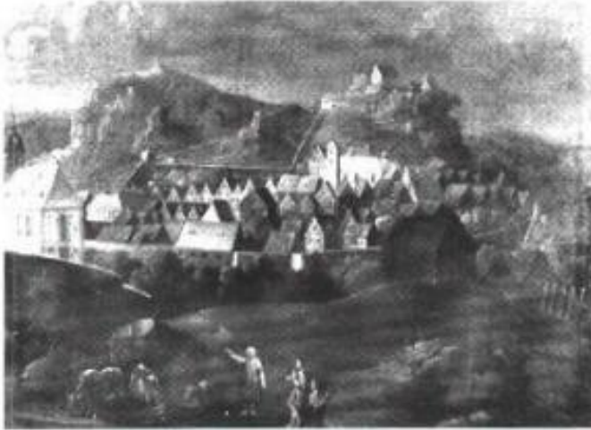
Ölgemälde von Seb. Förtsch 1802
