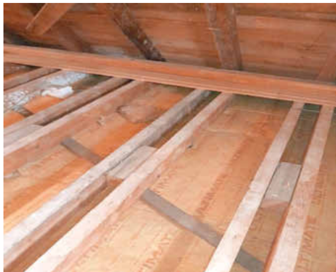
Die neu eingebrachte Dämmung
