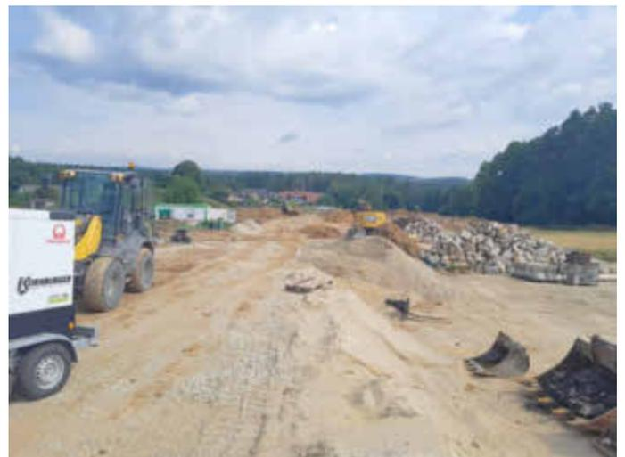
Im Regenthaler Baugebiet „Breitäcker II“ wird das Versickerungsbecken ausgehoben. Der Erd- und Kanalbau haben ebenfalls schon begonnen. Auch hier werden anschließend - wie in Kühlenfels - die Versorgungsleitungen verlegt.
